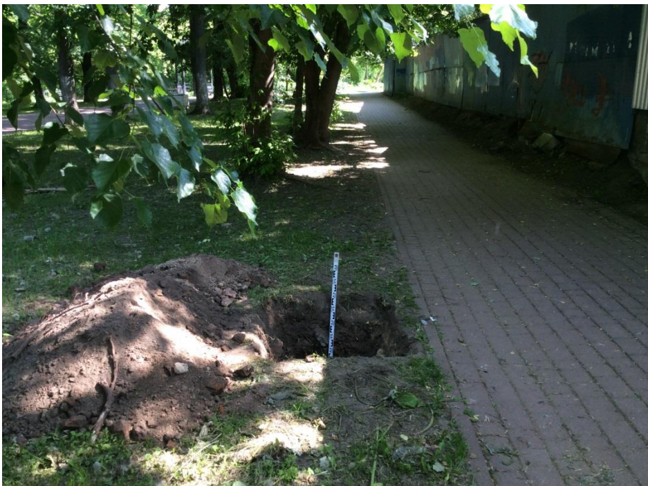
Рис. 12. Земельный участок под объект «Строительство кабельных линий (перекоп), питающих четырехэтажный кирпичный производственный корпус АО «КНИИТМУ» по адресу: г. Калуга, ул. Пушкина, 19, от городских подстанций РП-3 и РП-19». С обозначением видовых точек. Шурф 1. 2023 г. Вид с юга.
